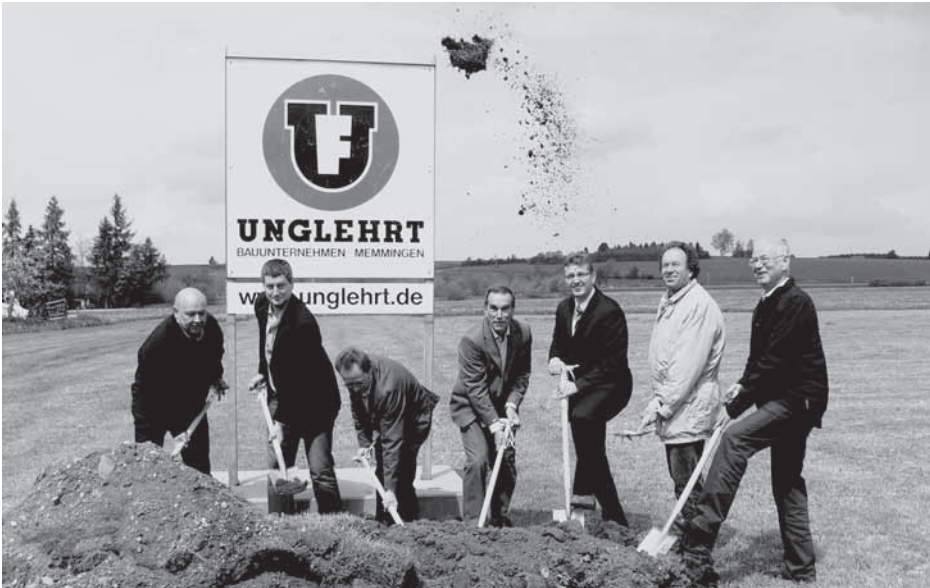
auf dem Bild (von links nach rechts): Projektleiter Werner Wollbeck, Josef Waldmann, betreut das Projekt vor Ort, Architekt Peter Rapp, Bauherr Ludwig Jakob, Dr. Alexander Versch (Geschäftsführer T & S Jakob), Thomas Unglehart von der gleichnamigen Baufirma und Erster Bürgermeister Wolfgang Schramm
